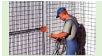
Colocado de tubo flexible
