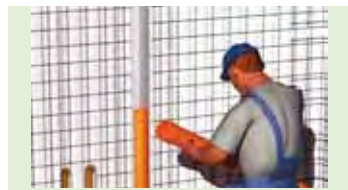
Colocado de tubo rígido
