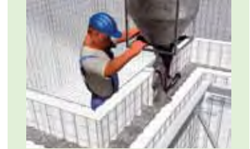
Vaciado en paneles dobles
