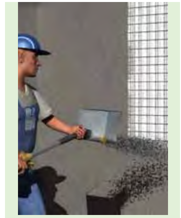
Rociado para revestimiento
