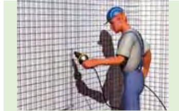
Fundido de canales
